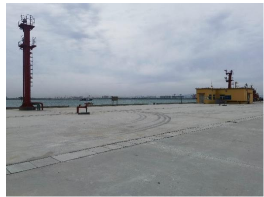
2#码头施工后图 2
