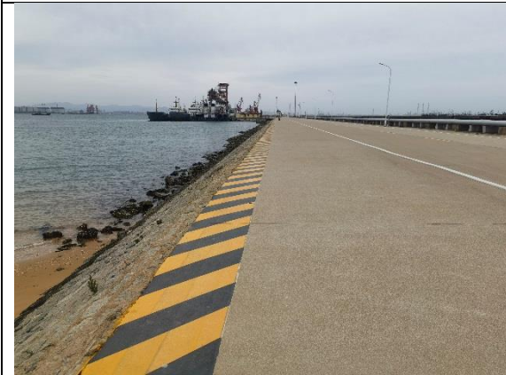
2#码头施工后图 1
