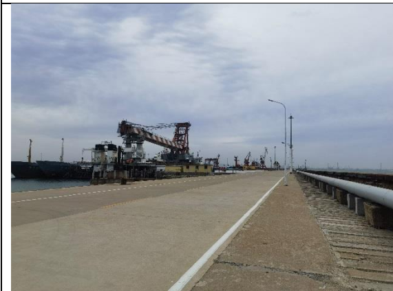
2#码头施工后图 3
