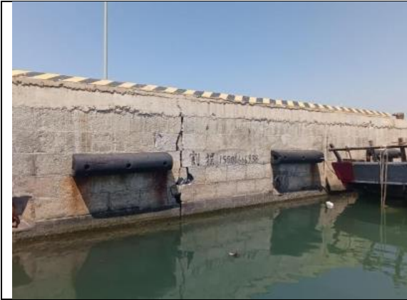
2#码头施工前图 1
