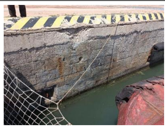
2#码头施工前图 2
