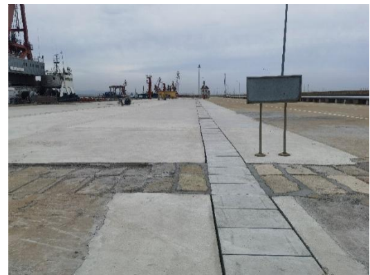
2#码头施工后图 4
