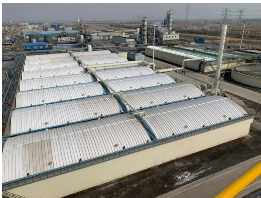
污水处理全景
