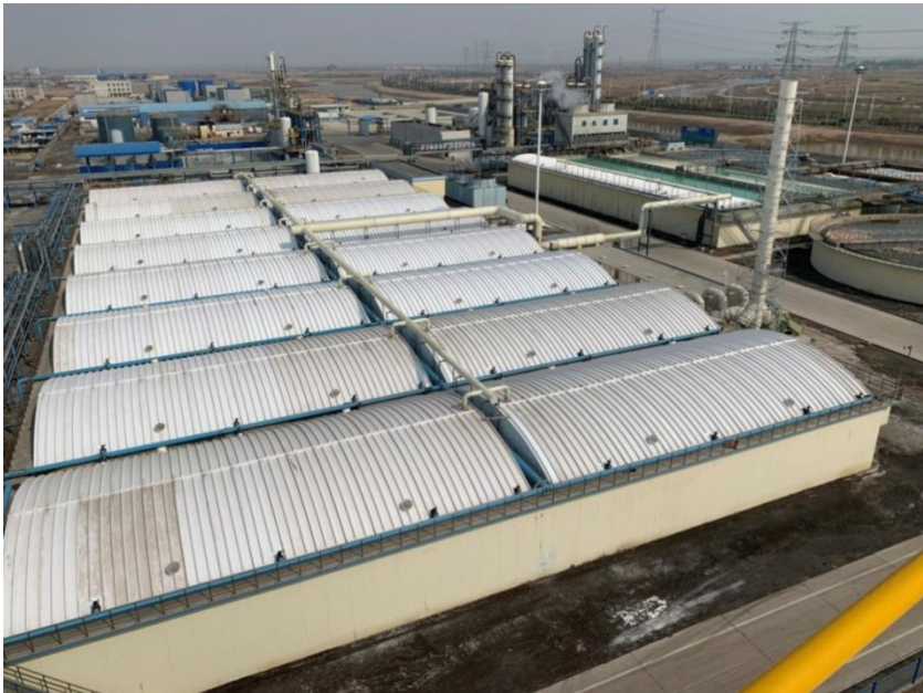
污水处理全景
