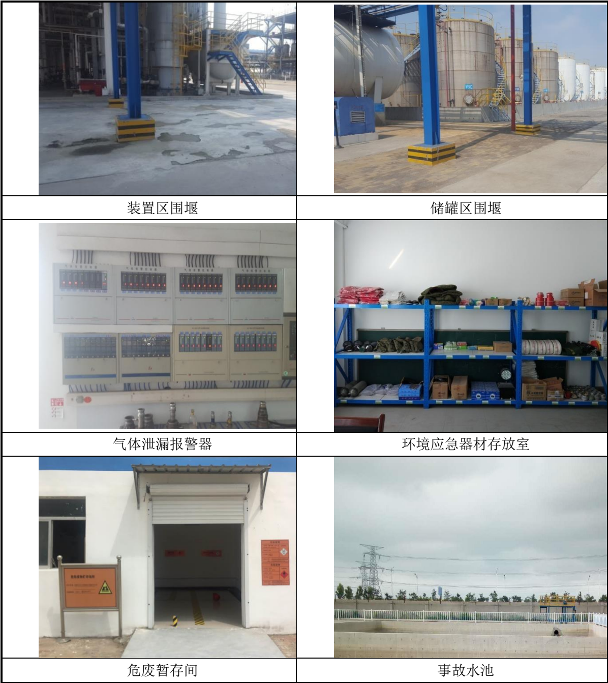
图6.8-2 现有工程应急处置措施照片图
