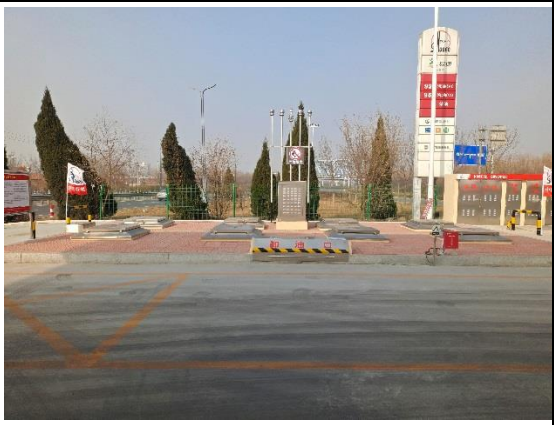
罐区及油气回收
