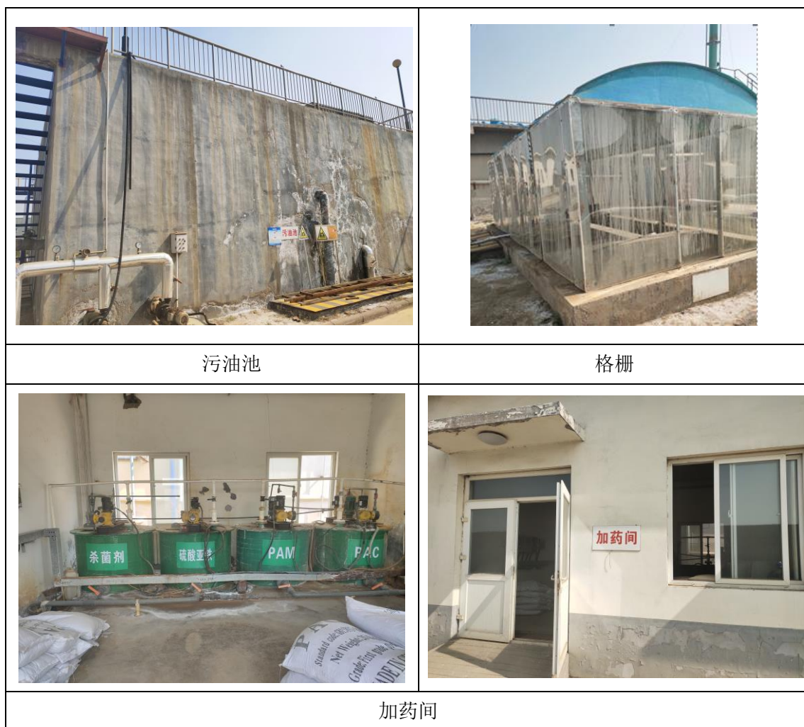
图 3.3-1 项目现场照片
