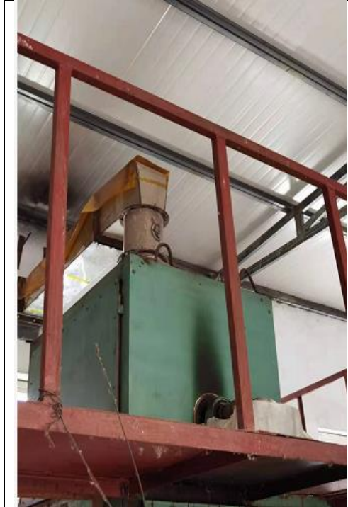
车间废气收集装置（烘干、流延、上胶、抽真空）
