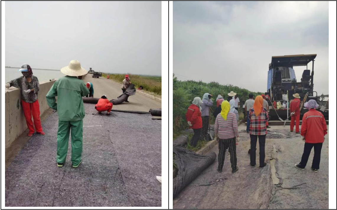
附件 4 施工期照片
